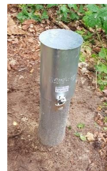
Figuur 2 Voorbeeld peilbuisafwerking waterschap
