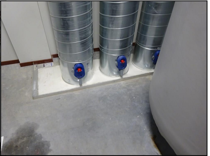
brandscheiding tussen verdieping en begane grond
