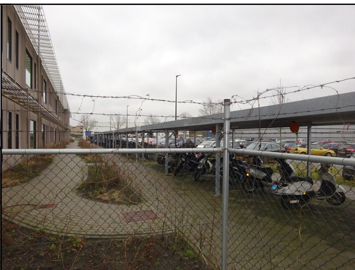
fietsenberging zuidwestzijde tussen pand en parkeerterrein
