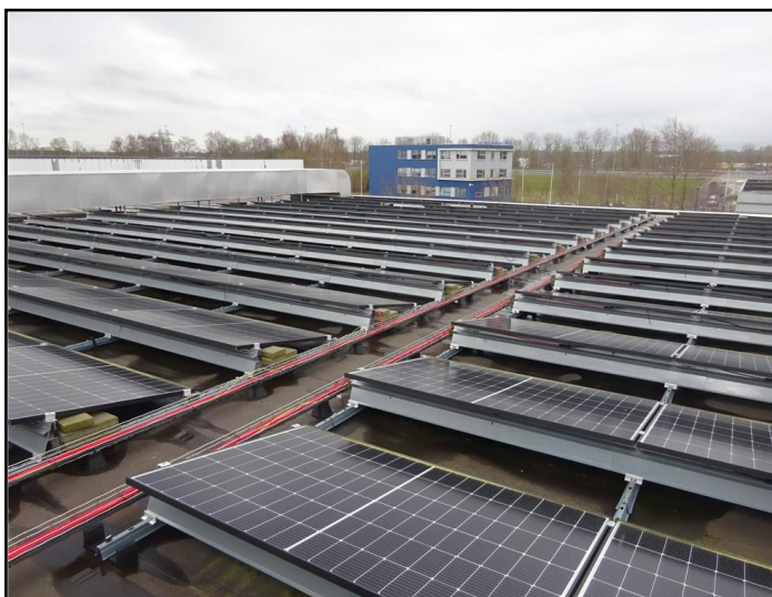
deel van het dak
