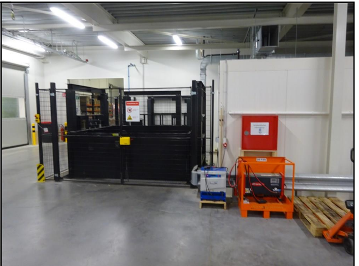
goederenlift magazijn 1e verdieping met bovenzijde koelcel begane grond
