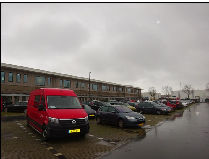
zuidwestgevel vanaf parkeerterrein
