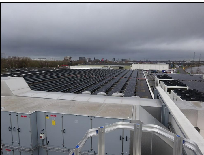
deel van het dak
