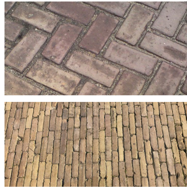
hergebruik bestaande gebakken gele en rode klinkers
