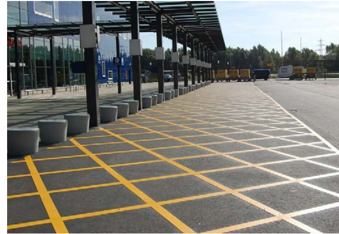
veilige en helder gemarkeerde oversteekplaatsen en verblijf- plaatsen
