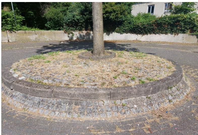
foto C; vlakke en verticale keien
