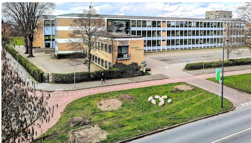
Figuur 1: Bestaand gebouw hoofdingang Groen van Prinstererlyceum
