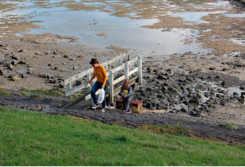
Toegang tot wad via het buitentalud
