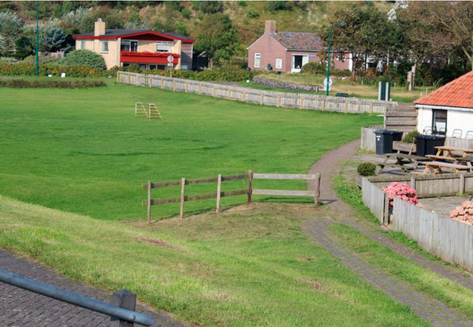
In het landschap is het historische tracé van de dijk aan de westzijde nog herkenbaar.
