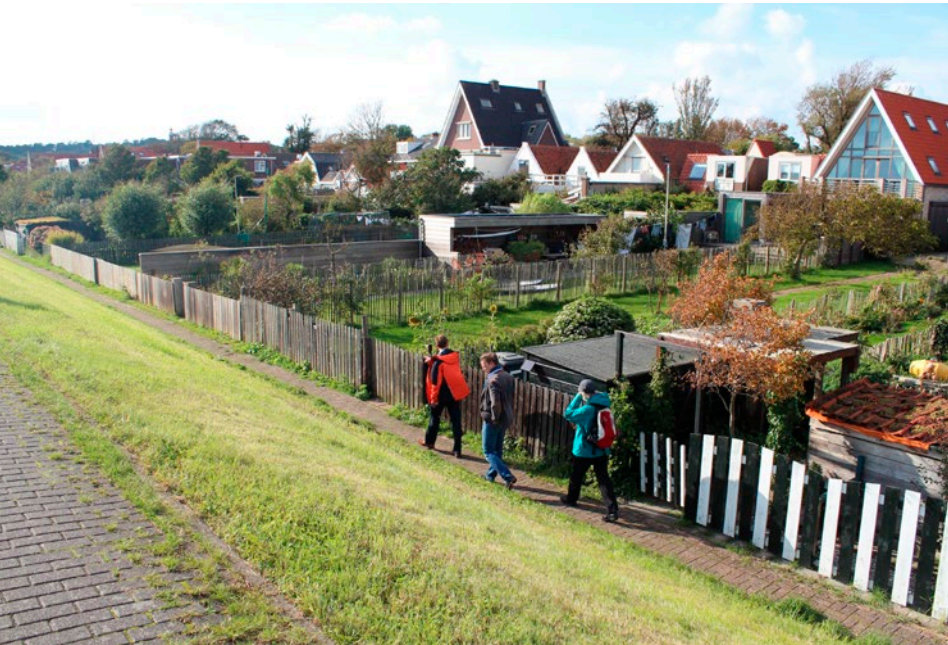
Percelen zijn direct gelegen aan de dijk, er ligt een smal pad tussen de tuinen en teen van de dijk. Vanuit de woningen is er zicht op de dijk en de Waddenzee
