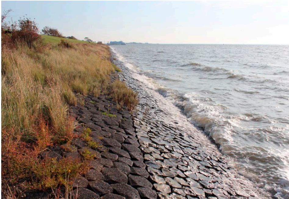
Verschillende typen steenbekleding onderaan het buitentalud, vegetatie tussen het basalt
