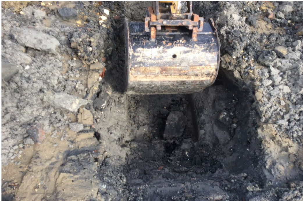
Sleuf S01, foto 1
