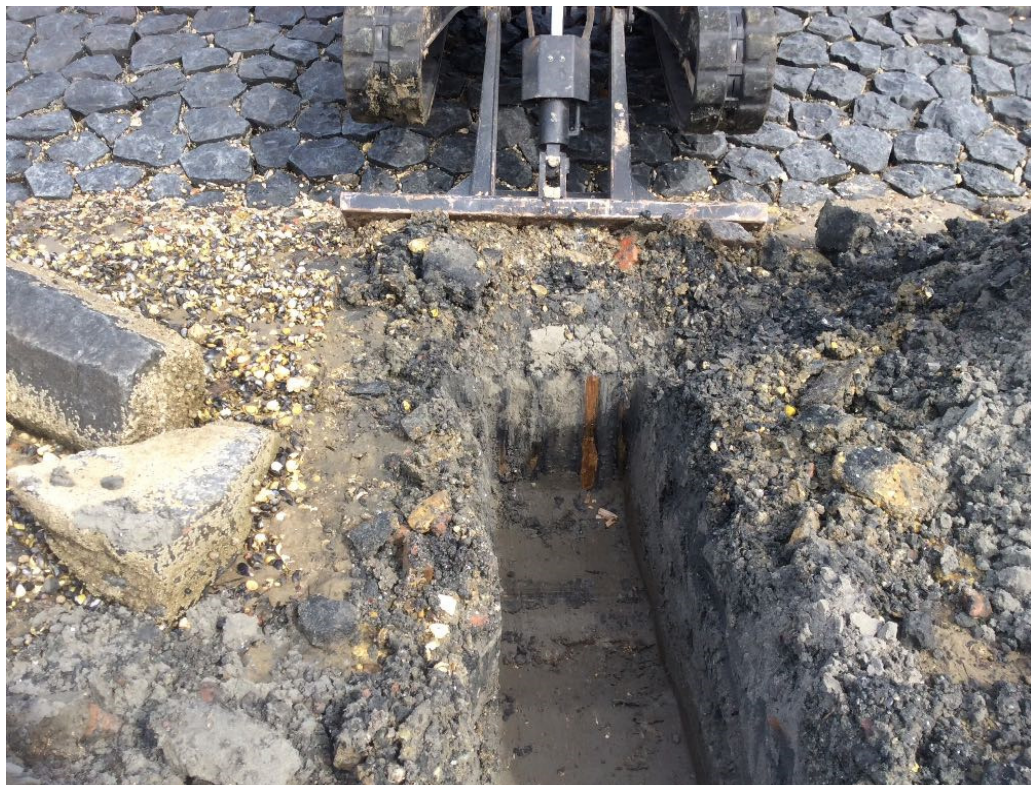
Sleuf S01, foto 2
