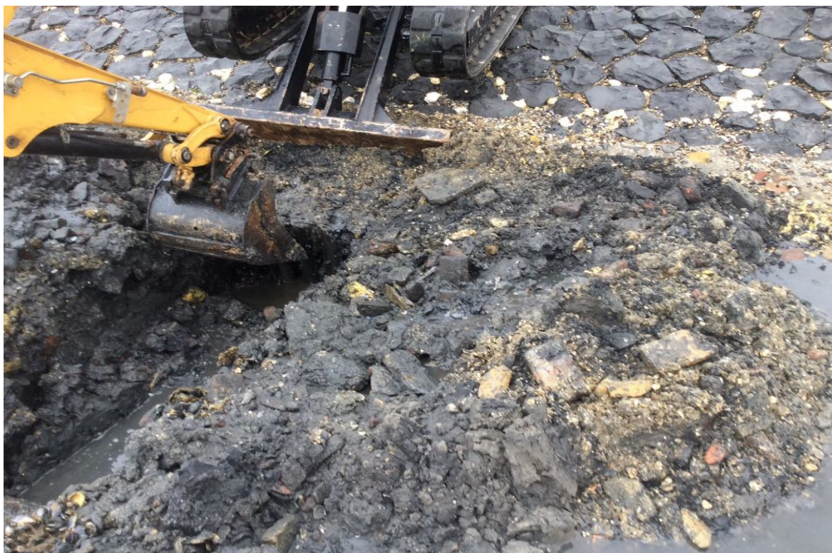
Sleuf S03, foto 2
