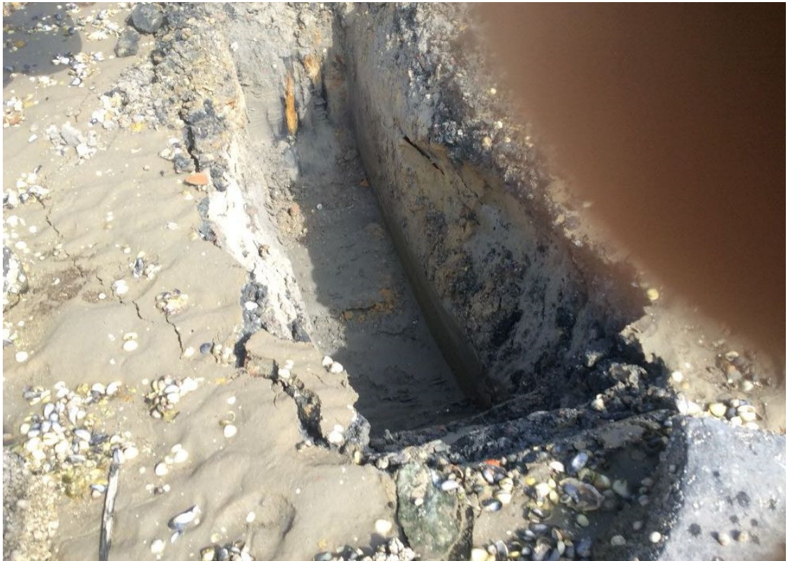
Sleuf S02, foto 1
