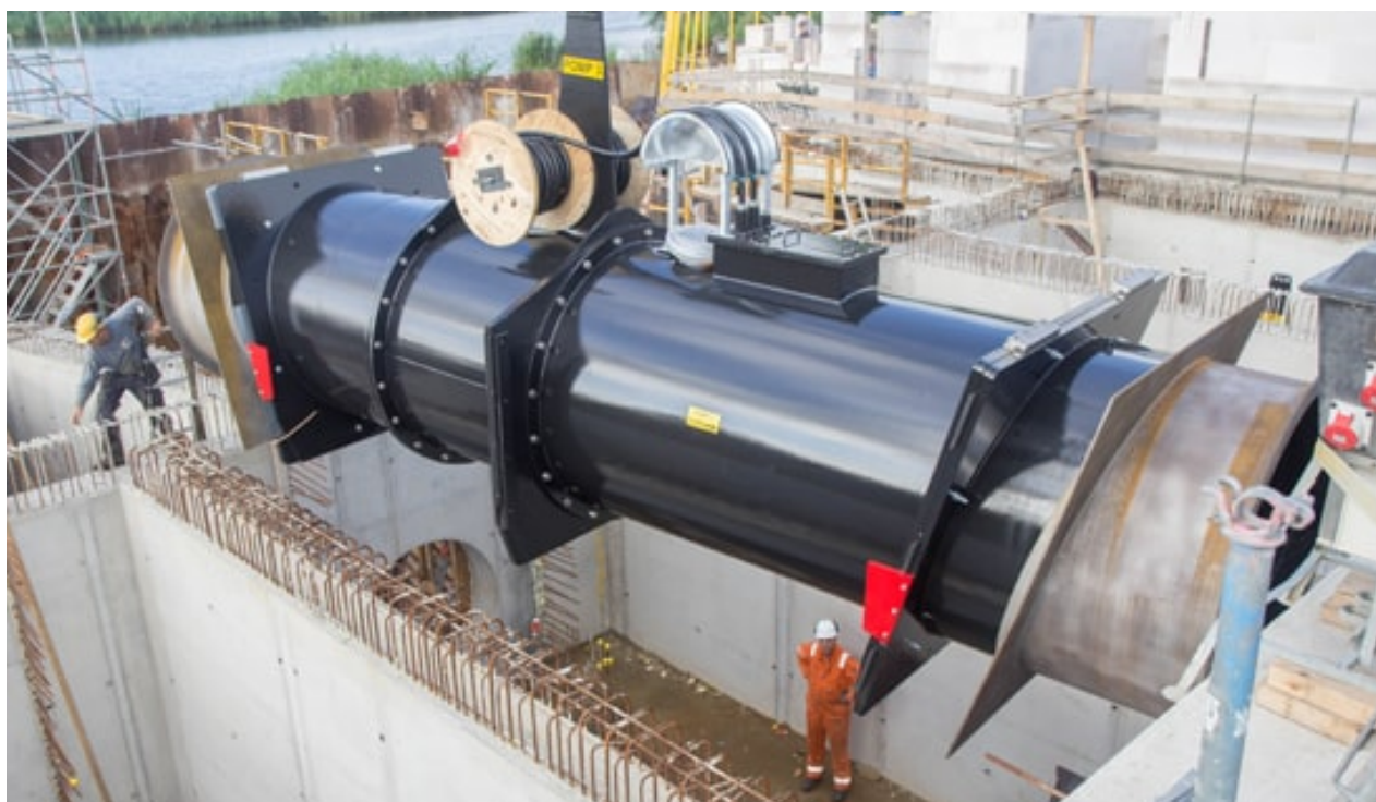
Figuur 26: Voorbeeld visvriendelijke horizontale pomp die tevens geschikt is als waterkrachtturbine
