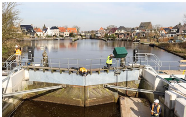
Figuur 17: Voorbeeld afsluitmiddel met puntdeuren in afgesloten (links) en open stand (rechts)
