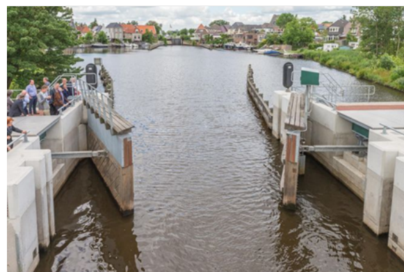
Figuur 17: Voorbeeld afsluitmiddel met puntdeuren in afgesloten (links) en open stand (rechts)
