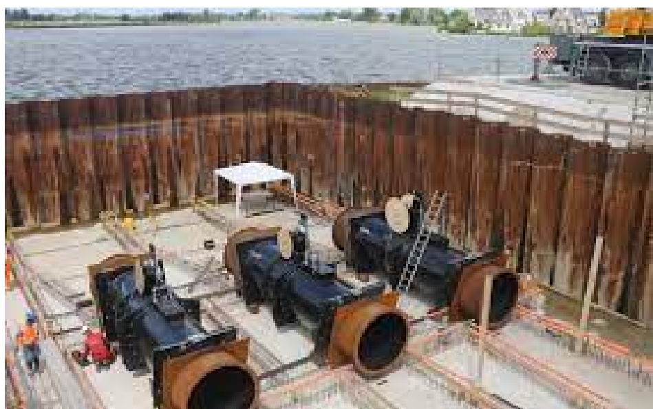
Figuur 15: Voorbeeld van 3 horizontaal opgestelde pompen in een bouwkuip
