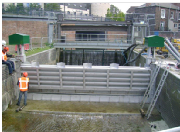
Figuur 19: Voorbeeld afsluitmiddel met klepstuw (links gestreken/open en rechts opgezet/kerend)
