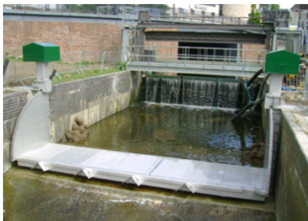
Figuur 19: Voorbeeld afsluitmiddel met klepstuw (links gestreken/open en rechts opgezet/kerend)
