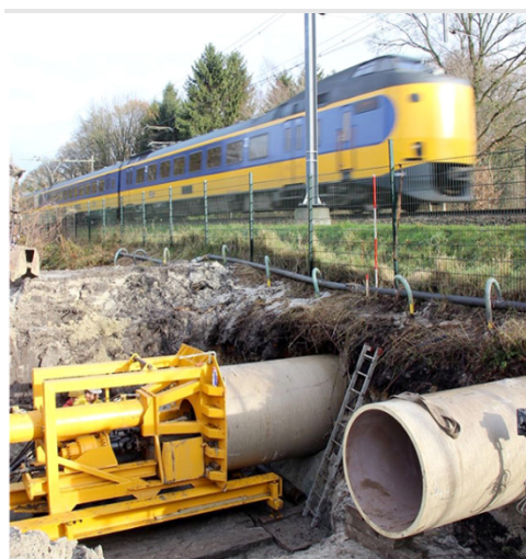
Figuur 25: Voorbeeld sleufloos aanbrengen persleiding
