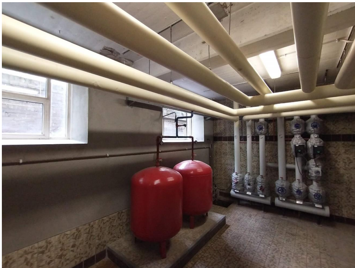
Afbeelding 4.4 impressie van een kelderruimte
