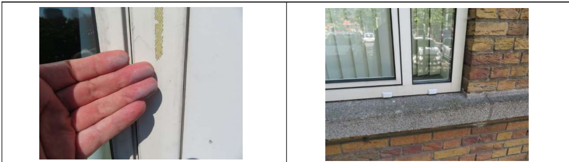
Aantasting / vervuiling van prepaint afwerklaag van de aluminium kozijnen =>
