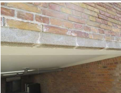
Scheuren in rand van de vloer en gebroken glazen bouwstenen =>
