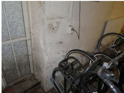
Vochtschade aan ter plaatse van de entree van de fietsenstalling =>
