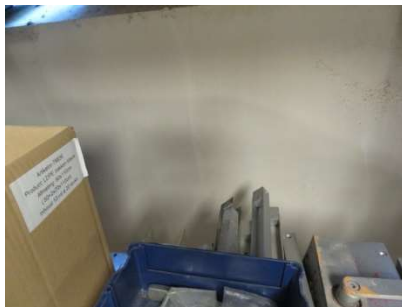
Vochtschade aan de binnenzijde van de gevels in het souterrain =>
