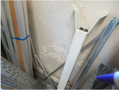
Vochtschade aan de binnenzijde van de gevels in het souterrain =>
