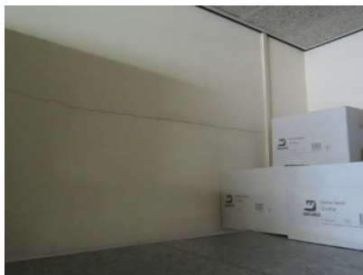
Horizontale scheurvorming in de tussenwanden van het souterrain =>
