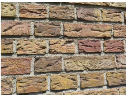
Incidenteel verzand en/ of uitgespoeld voegwerk =>
