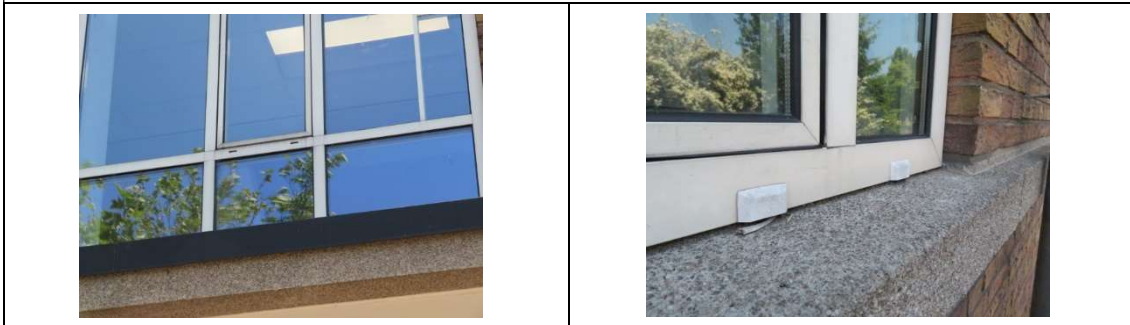
Aantasting / vervuiling van prepaint afwerklaag van de aluminium kozijnen =>
