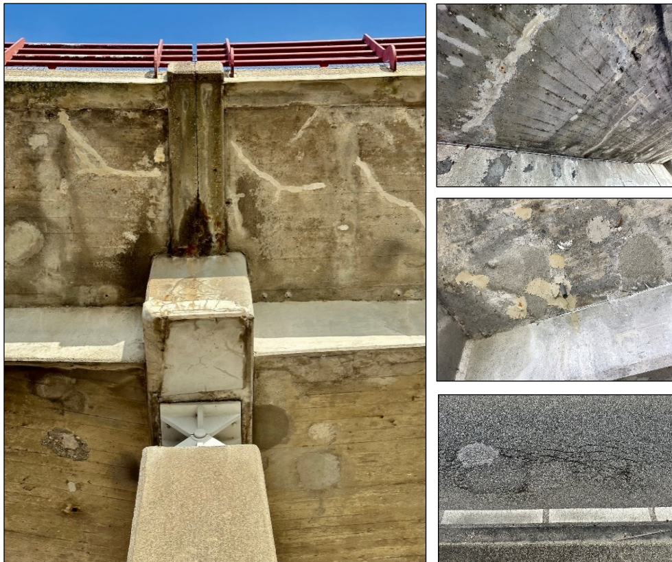
Figuur 10 - Impressie betonwerkzaamheden
