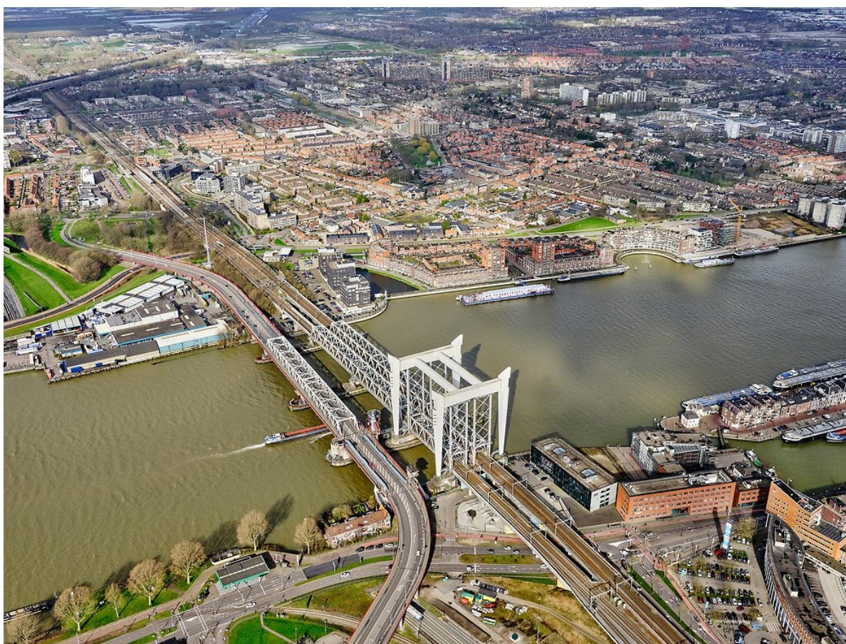
Figuur 2 - Bovenaanzicht Verkeersbrug Dordrecht
