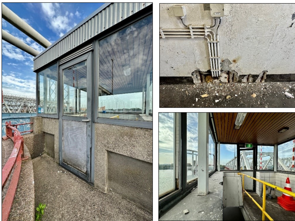
Figuur 17 - Impressie bouwkundige werkzaamheden
