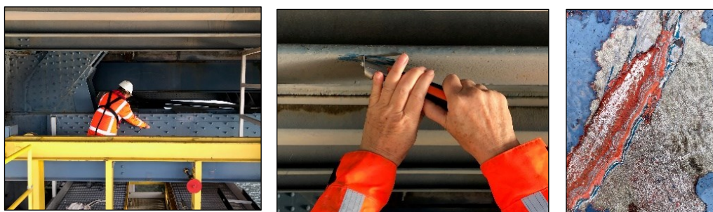
Figuur 6 - Impressie conserveringswerkzaamheden
