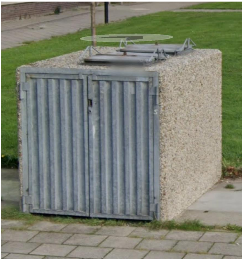
Bestaande betonnen cocon met rolcontainer voor GFT
