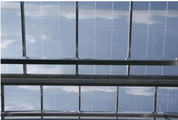
Afbeelding 6.2 – Voorbeelden van zonnepanelen in glas.
