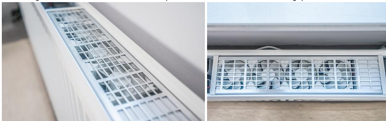
Afbeelding 5.1 – Radiatorboosters zoals die op bestaande radiatoren worden toegepast.
