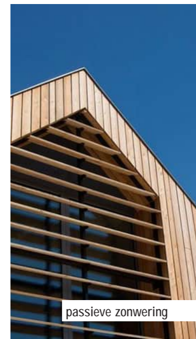
Vezelcementplaten hergebruiken als zonwering
