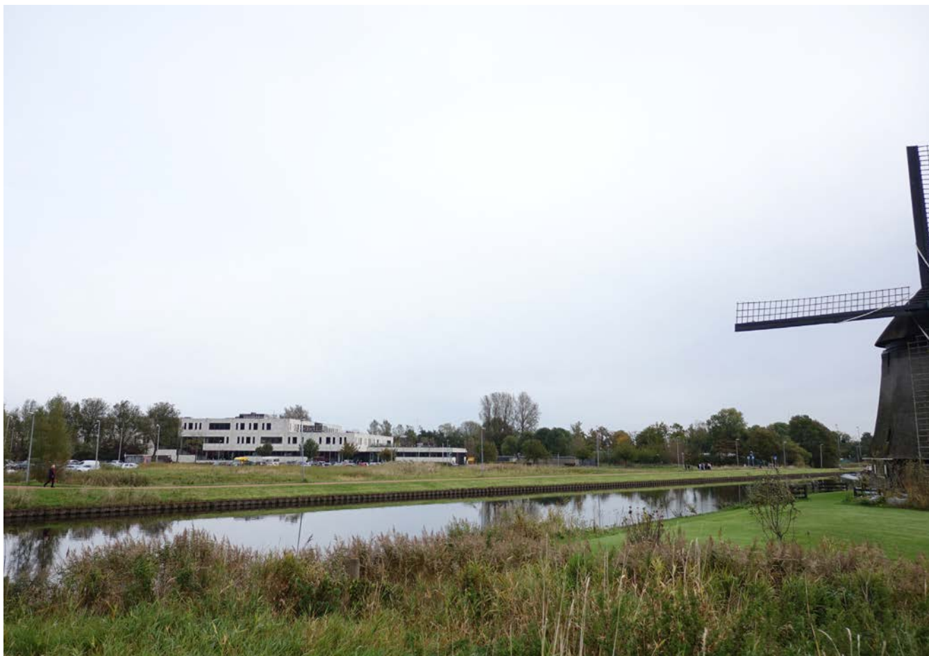
Bouwlocatie in huidige staat met het van der Meijcollege, de Hoornsevaart, de molenkade en bestaand groen
