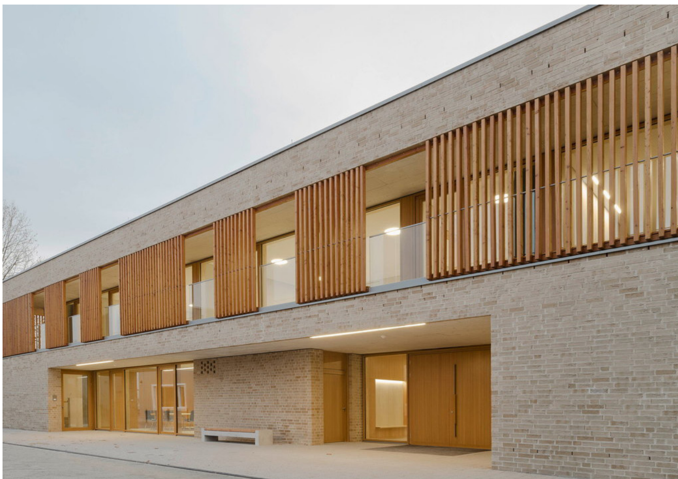
De entree(s) van de Europese school zijn zichtbaar en herkenbaar ontworpen als architectonisch onderdeel van de gevelcompositie
