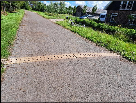
Figuur 4.3 Amfibieëntunnel ter hoogte van Gedempte veert 143
