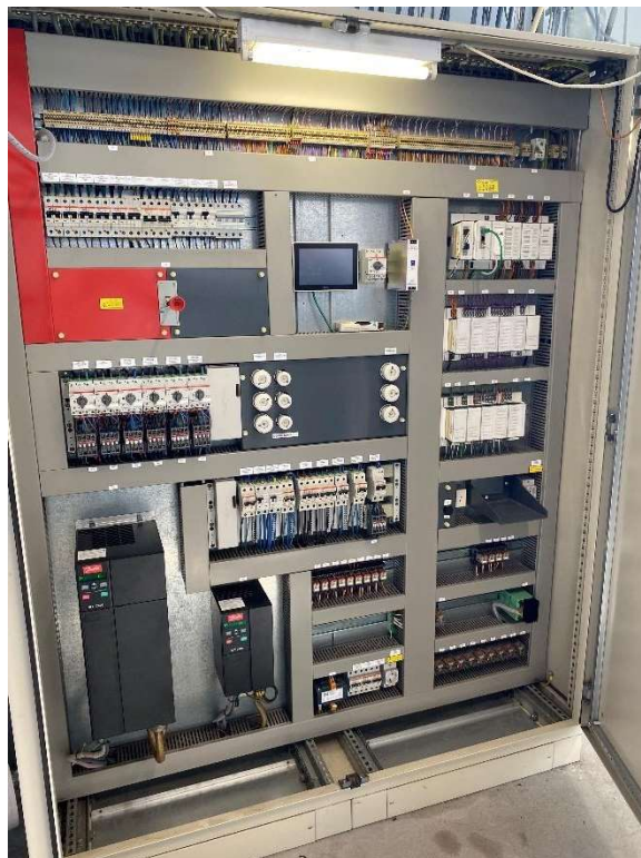
Frequentie regelaar luchtbehandeling in regelkast Carrousel
