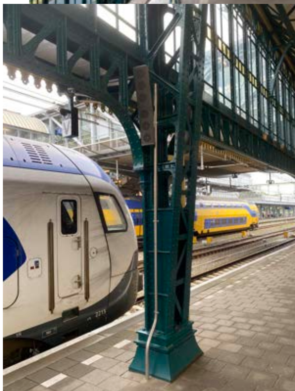
Constructie perronoverkapping 's-Hertogenbosch, 2023. Foto: Contrei
