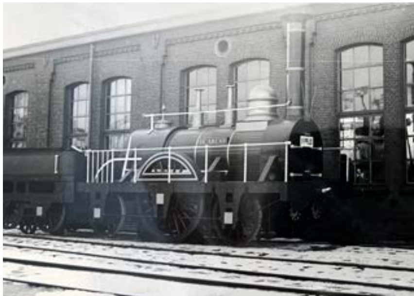
Locomotief aan de noordzijde van de Schrijnwerkerij, 1939-1955. Foto: Nederlandse Spoorwegen. Toegangsnr.: 955 Invnr.: 1015. <HUA>
