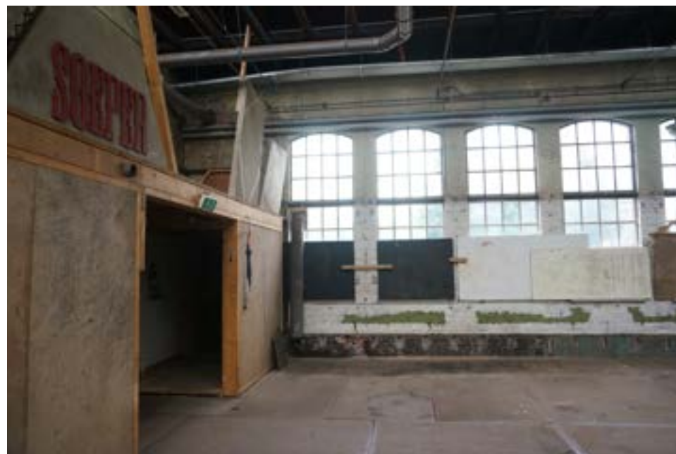
W. 47 links het houten entreehok.
