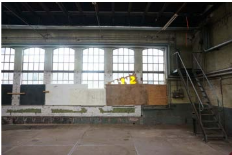
W. 46 zuidgevel met balk balkinkassingen.
