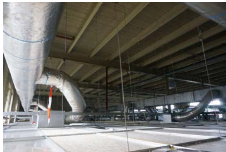
S. 4 foto richting westen, boven plafond.
