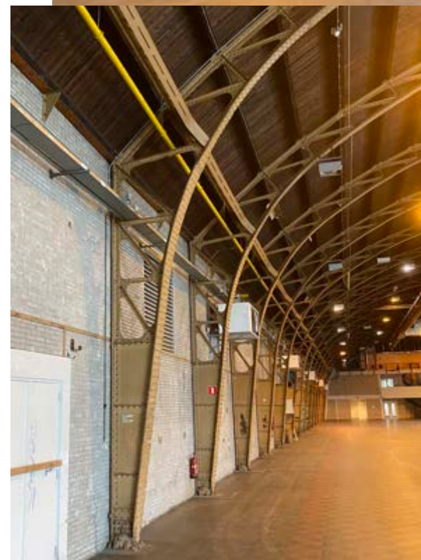
Constructie Koepelhal, 2023. Foto: Contrei
