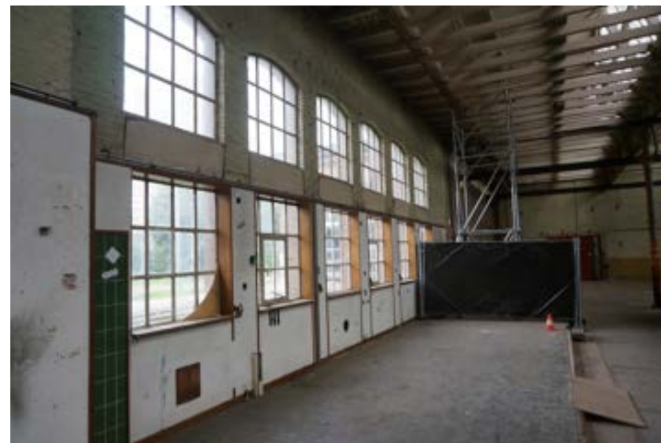
W. 7 locatie voorheen kantoortjes zuidgevel met opstorting vloer.
