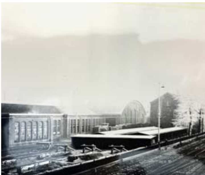
Wagenmakerij III en Koepelgebouw gezien vanaf zuidzijde. Rechts de voormalige woning chef werkplaats. 1913-1939. Foto: Nederlandse Spoorwegen. Toegangsnr.: 955 Invnr.: 1014. <HUA>
