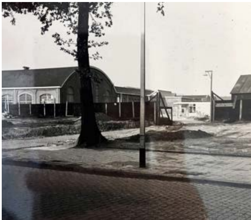
Bouw van een nieuwe portiersloge ten noorden van Wagenmakerij III, 1955-1968. Foto: Nederlandse Spoorwegen. Toegangsnr.: 955 Invnr.: 1016. <HUA>
