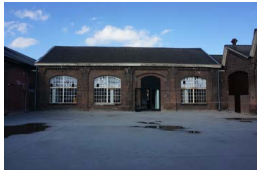
ZH. 3 gevel Bankwerkerij.
