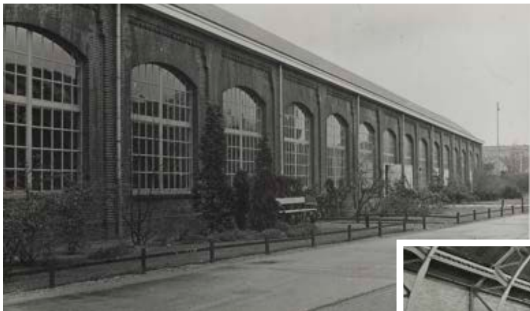
Oostzijde van de Koepelhal. De deuren waren toen al aanwezig. 1951. Foto: Spoorwegmuseum. <GVN>
