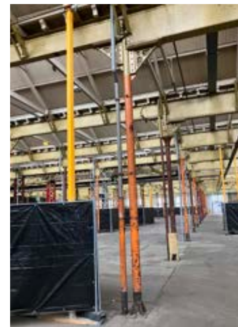
Vervangen kolom.
