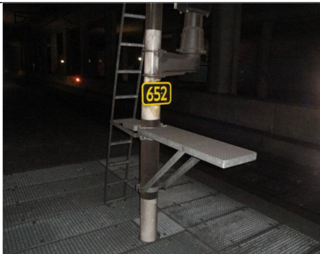
Foto 2: Bordessen van seinen hangen op gevaarlijke hoogte. Het is mogelijk dat iemand er tegenaan loopt.
