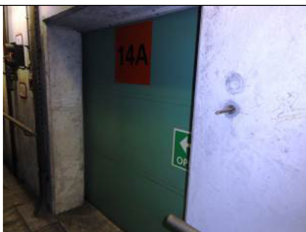
Foto 4.3: Uitstekende meetstaaf op ooghoogte deur 14A
