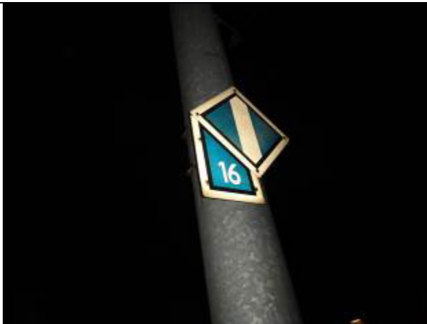
Foto 5.12: Scheiding tussen 1500 V en 25 kV
