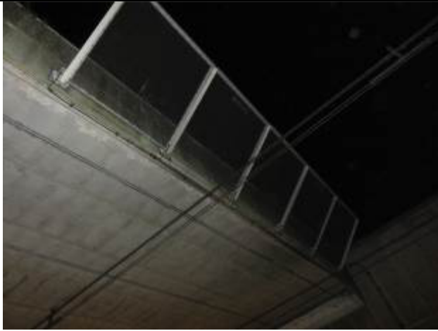
Foto 2.7: Afscherming bovenleiding
