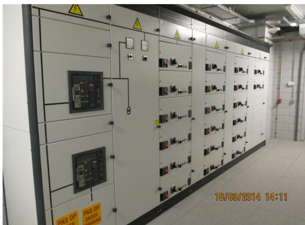
Foto 18: Laagspanningsverdeelinstallatie (LSVI) Dienstgebouw Zuid (690V)
