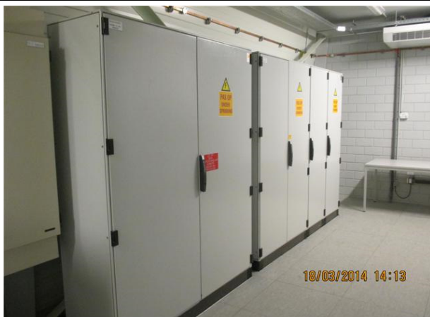
Foto 20: Laagspanningsverdeelinstallatie (LSVI) Dienstgebouw Zuid (B2 + B3)
