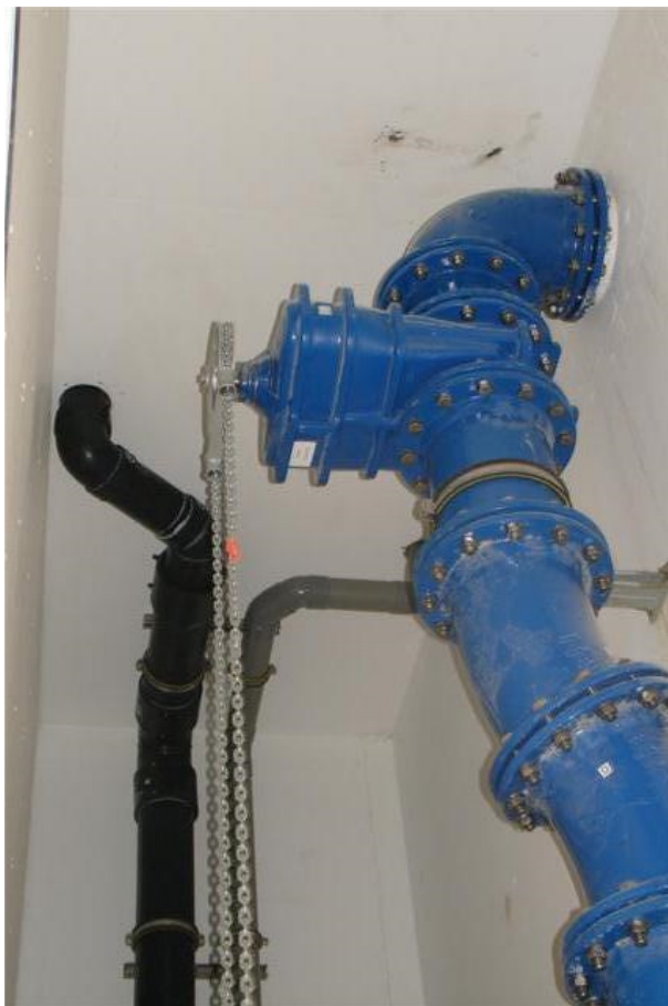
Foto 38: Kettingbediening hoofdafsluiters pompinstallatie Noord
