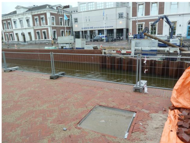
Foto 40: Inspectieluiken inlaatwerk blusleiding
