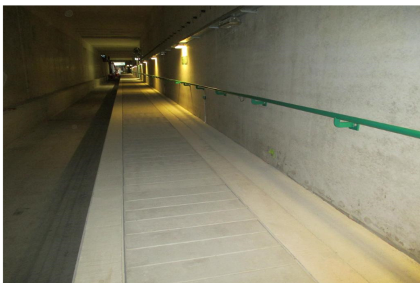
Foto 51: Betonnen platen kabelkoker/vluchtpad
