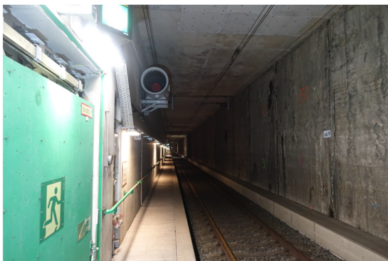
Foto 64: Diepwanden tunneldeel Noord.
