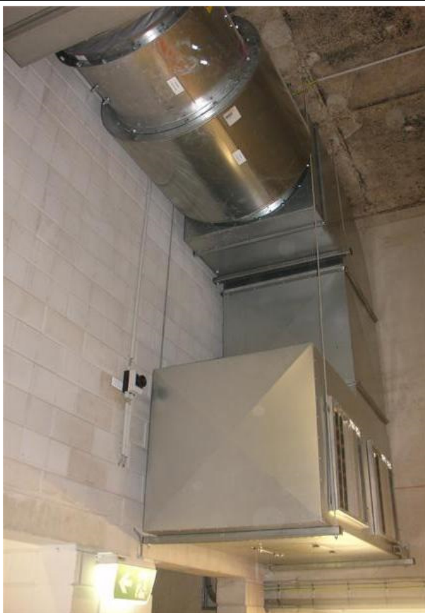
Foto 34: Overdruk-/stuwdrukinstallatie T1-OOST
