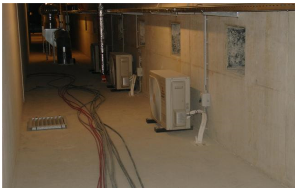
Foto 49: HVAC-installatie drukvereffeningsruimte Perronkop Noord
