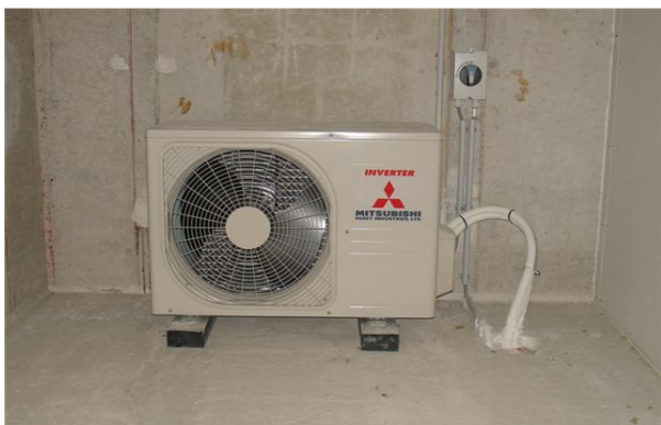
Foto 50: Condensoren HVAC-installatie Perronkop Zuid
