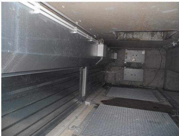
Foto 37: Besturingskast rookscher
