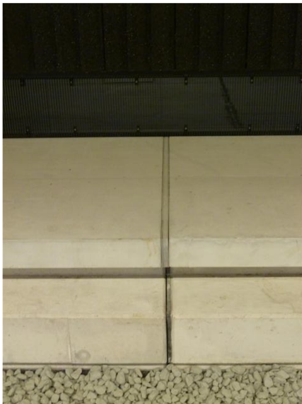
Foto 53: Dilatatieprofiel prefab middenbalk
