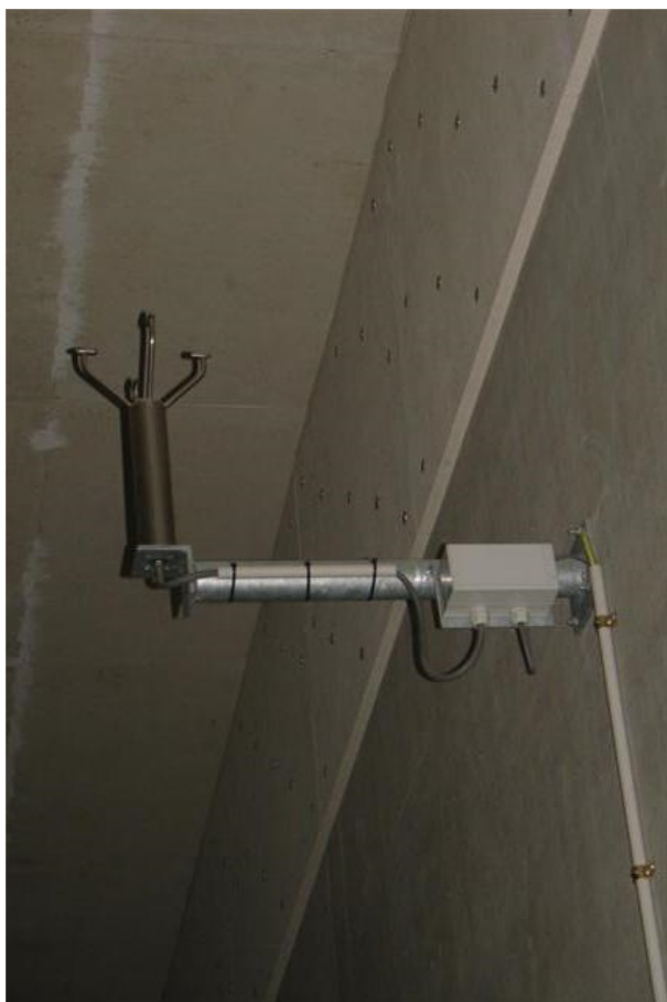
Foto 47: Sensor Meteo-installatie tunnel
