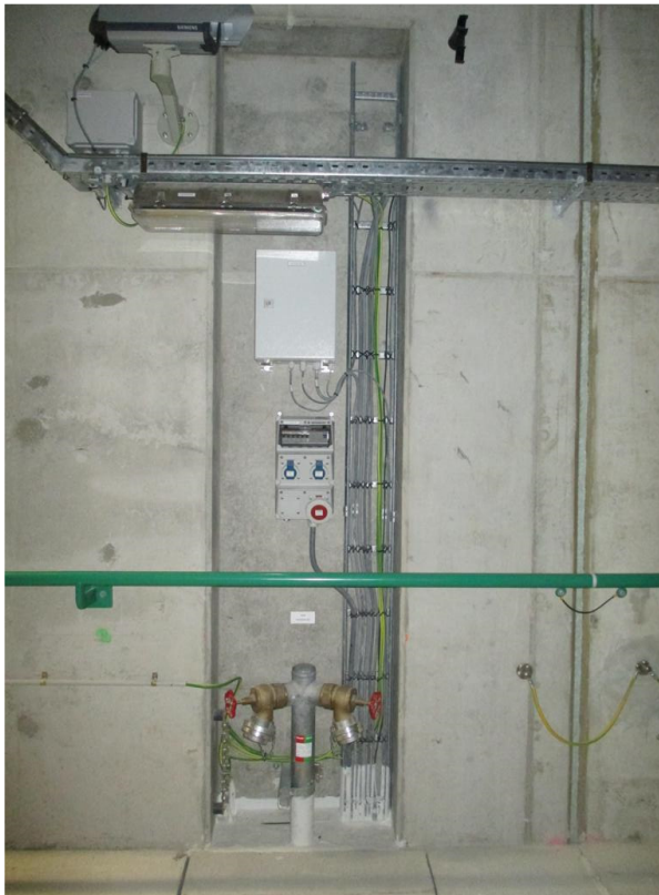
Foto 2: WCD-kasten Tunnel
