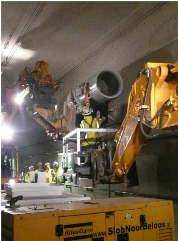
Foto 33: Hefplateau (t.b.v. ventilator tunnel)
