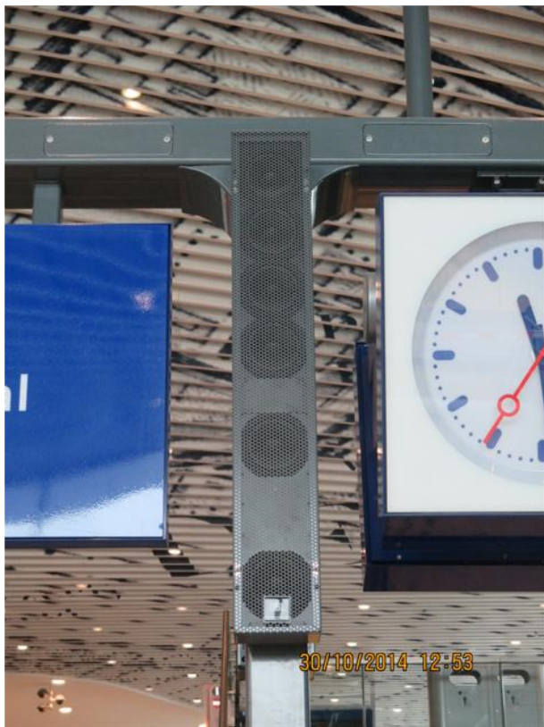
Foto 45: Omroep- en ontruimingssysteem
