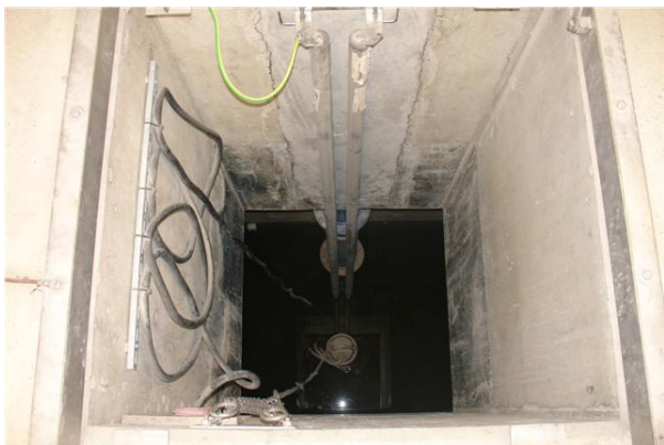
Foto 39: Pomp vloeistofopvangkelder Noord
