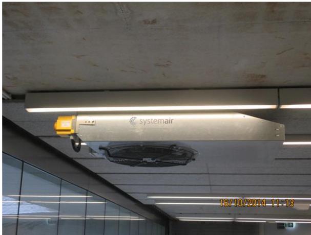
Foto 36: Stuwdrukventilatoren fietsenstalling
