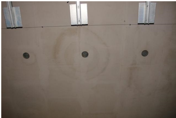
Foto 30: Afzuigat(en) RWA in tunneldek
