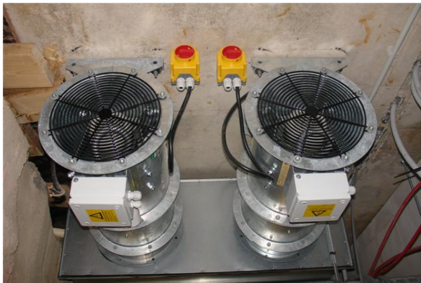
Foto 35: Toevoerventilatoren fietsenstalling
