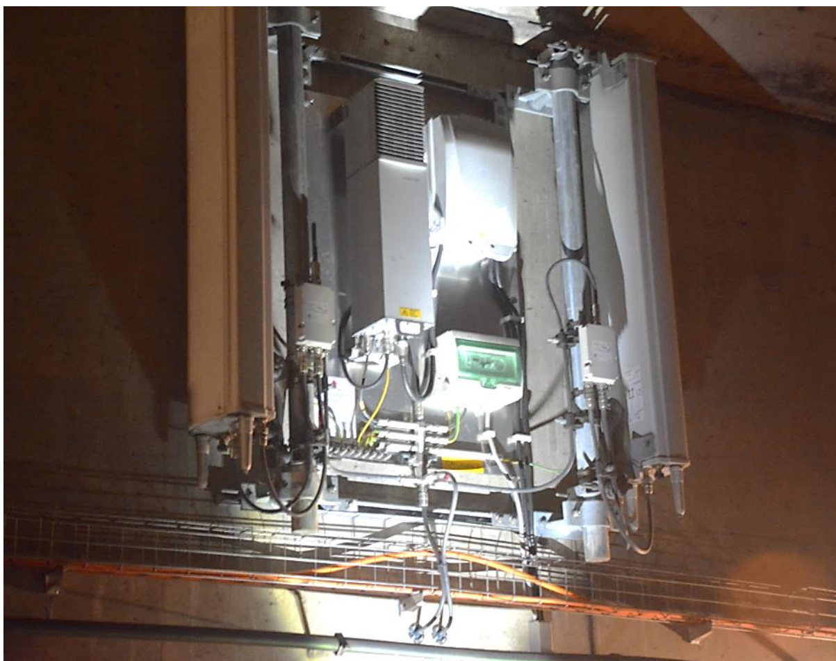
Figuur 23: ION 9 met twee antennes
