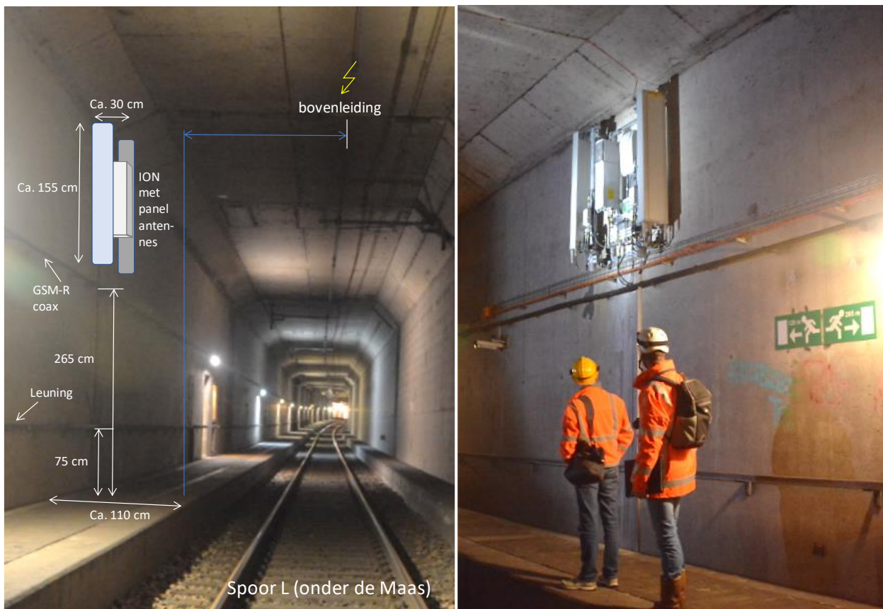
Figuur 12: Bereikbaarheid IONs en antennes. Linker montagefoto: Beoogde positie van de IONs met antennes op de tunnelwand. Beeld gemaakt richting Noord.
