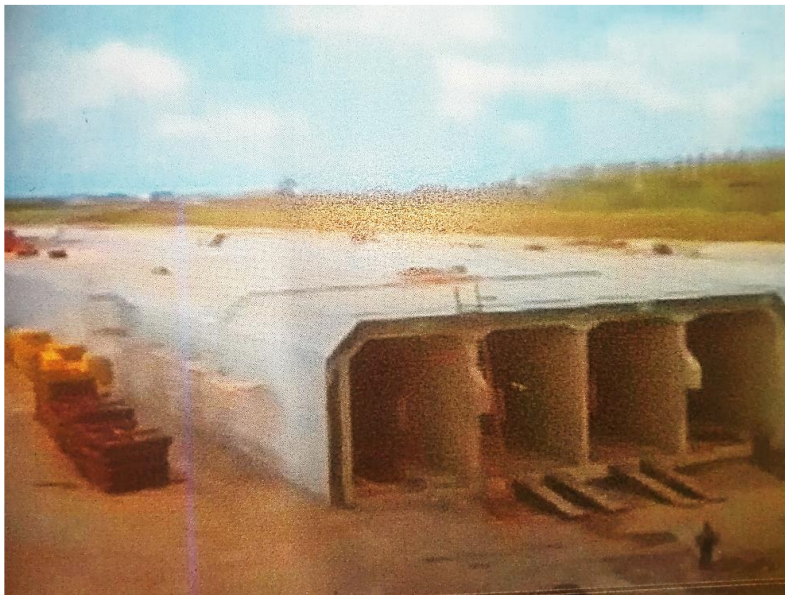
Figuur 1: Afzinkelement van de Willemsspoortunnel in aanbouw. Barendrecht, circa 1990
