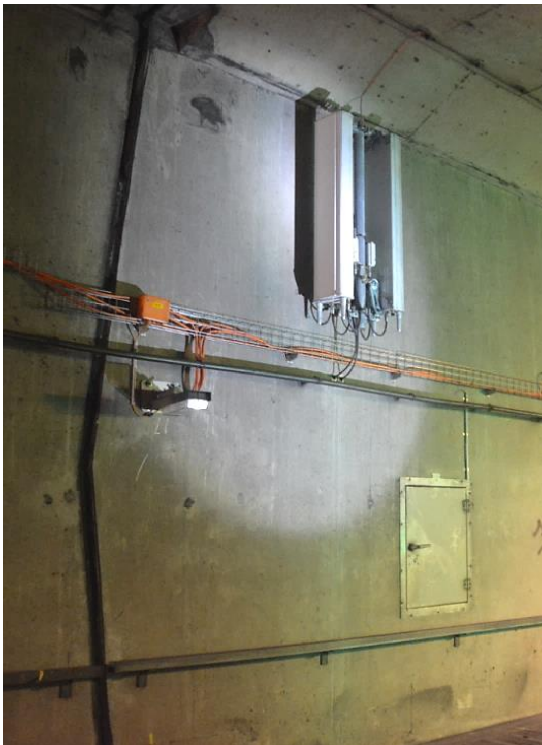
Figuur 21: Voorbeeld van een antenneopstelling die voor ION 3 en 4 ook is toegepast
