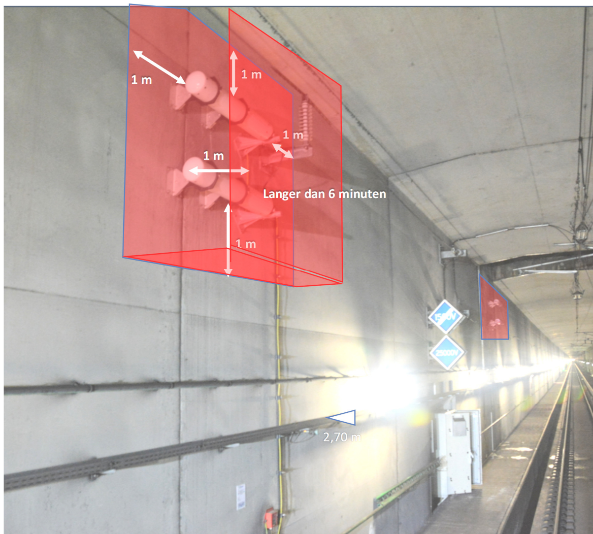
Figuur 14: Risicogebied van een yagi-antenne in rood aangegeven, praktijksituatie (spoor HSL buis 5 en dive onder)
