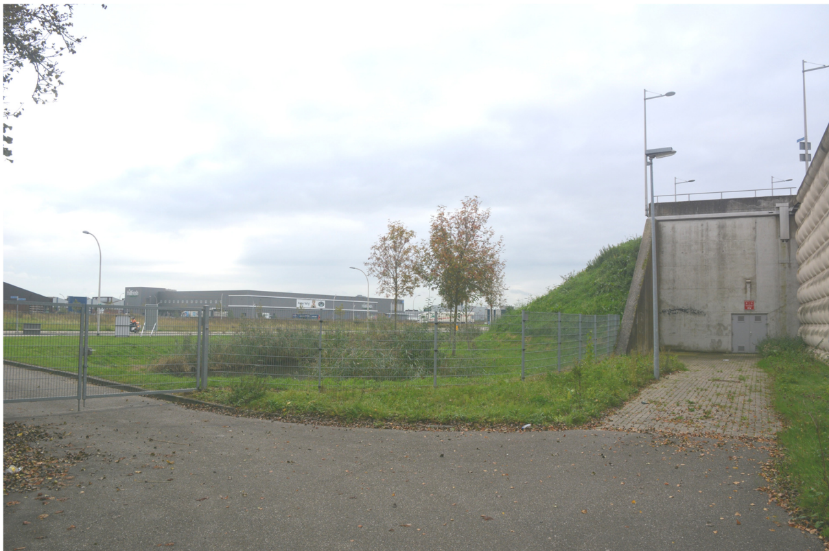
Figuur 3: Toegang tot de centrale apparatuur. Foto in zuidoostelijke richting
