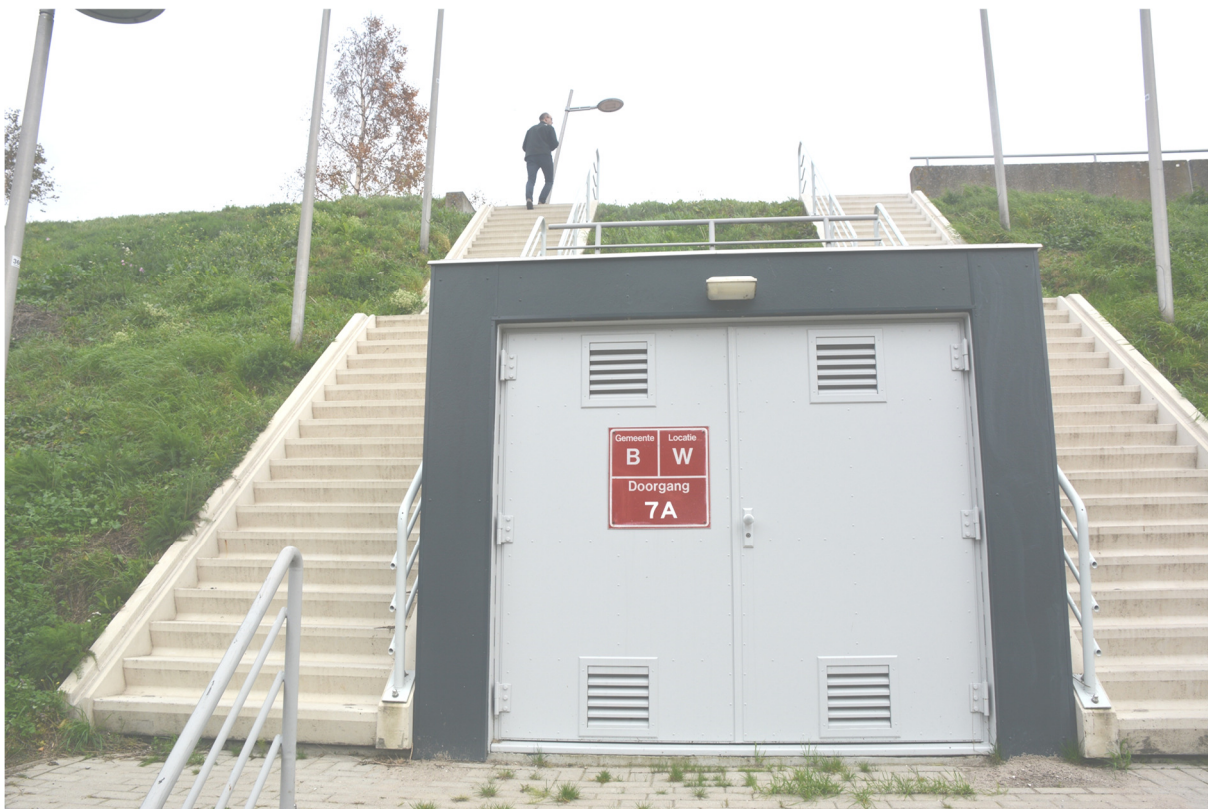
Figuur 7: Nooduitgang ORL 7. Aan de westzijde van de overkapping bij de zuidelijke tunnelmond
