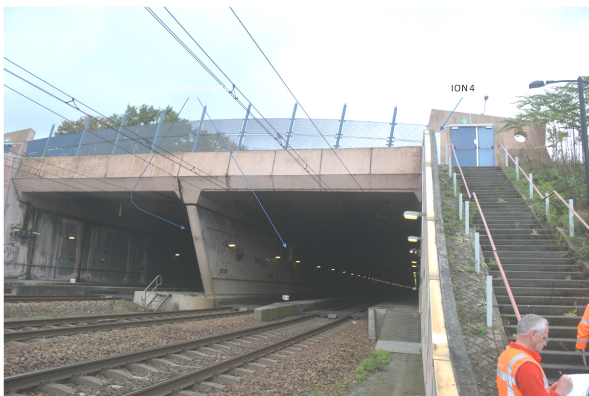
Figuur 10: ION 4, zuidzijde tunnel
