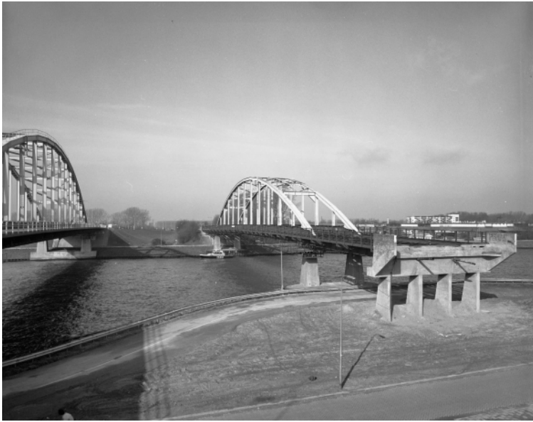
Foto: Gezicht op de, al gedeeltelijk ontmantelde Oudenrijnsebrug over het Amsterdam-Rijnkanaal te Utrecht
