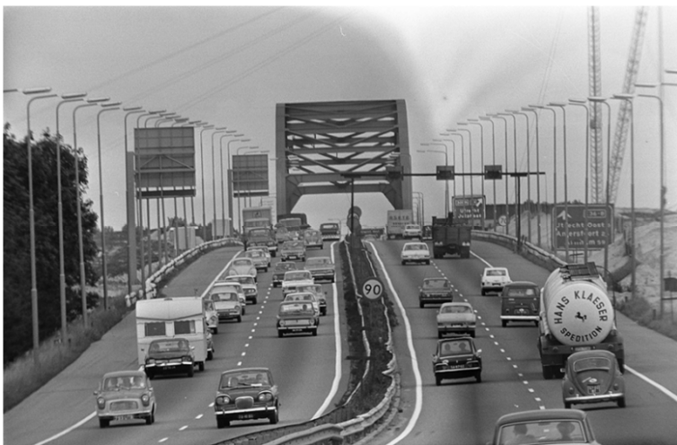
Foto: De oorspronkelijke brug uit 1939 was nog niet versleten en er werd besloten om de brug noordwaarts te verplaatsen om daarmee de Oudenrijnsebrug te vervangen.
