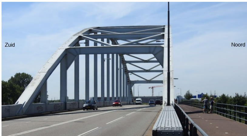
Foto: Gezicht op de boogbrug met het noordelijke fietspad
