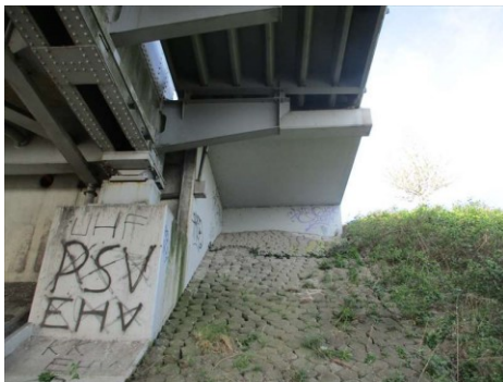
Vloerconstructie, staal, Verbreding noordzijde
