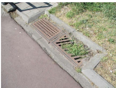
Hemelwaterafvoer (HWA), staal,
