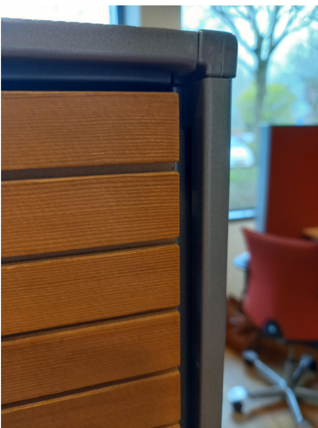
aanzicht wand met afdekkend profiel
