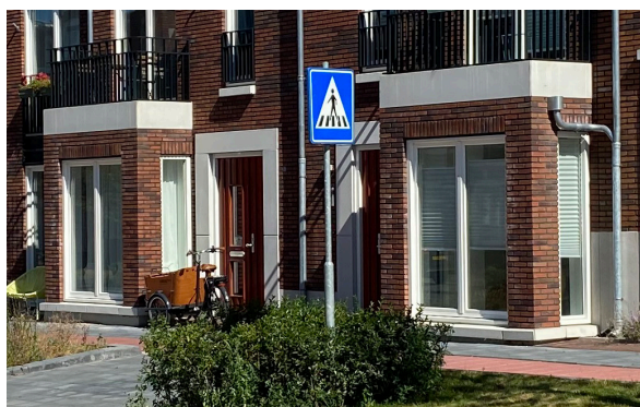
Ritmiek in erkers op begane grond
