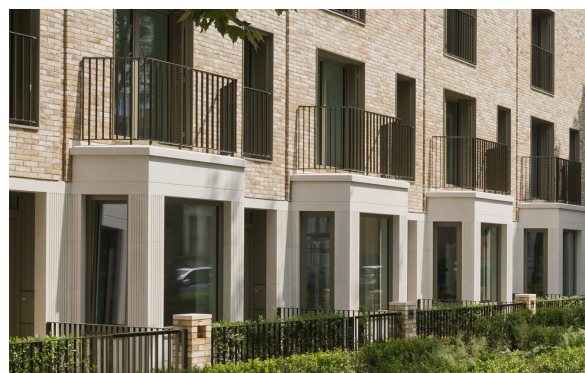
Ritmiek in erkers op begane grond
