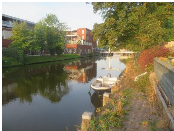
Figuur 2.9: Zicht op plangebied, op de kade muur die gerenoveerd wordt
