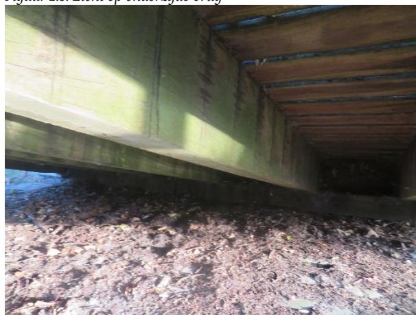
Figuur 2.7: Zicht op onderzijde brug
