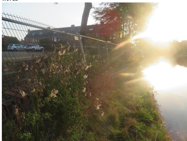
Figuur 2.10: Zicht op plangebied, op de kade muur die gerenoveerd wordt
