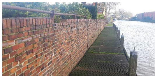
Geen verdachte elementen op of aan de kademuur
