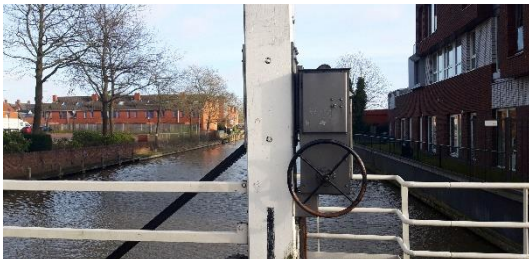
Geen verdachte elementen aan de hameitoren
