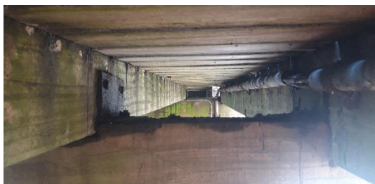
Geen verdachte elementen aan de onderzijde van de brug
