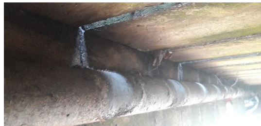
Geen verdachte elementen aan de onderzijde van de brug
