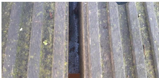
DPC folie onder de loopplanken
