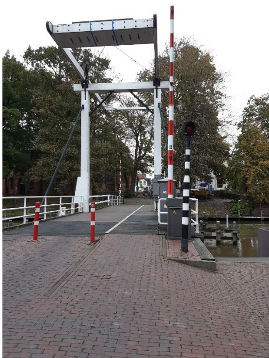
Figuur 2.2-2 Vooraanzicht bestaande brug
