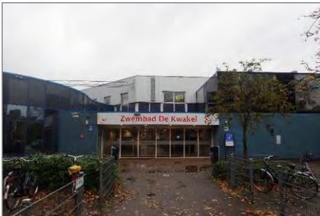
Afbeelding 3.1 | Deel 1 en 3: hoofdgebouw en entree
