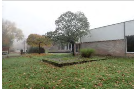
Afbeelding 5.8 | Deel 3: voormalig saunacomplex
