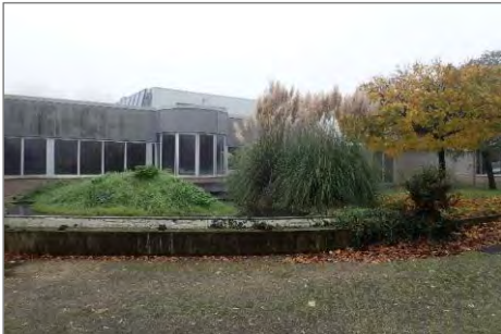
Afbeelding 5.7 | Deel 3: voormalig saunacomplex
