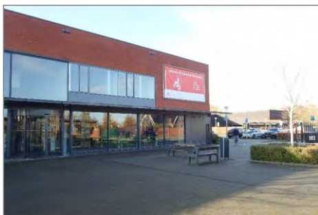
Afbeelding 2.1 | Deel 1 en 3: hoofdgebouw en entree
