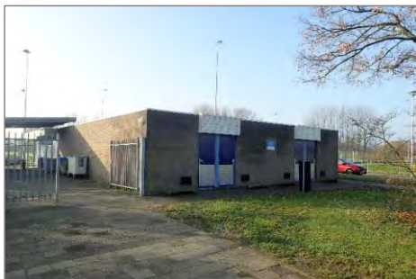
Afbeelding 7.1 | Deel 1: kleedruimtes (gebouw 1c)
