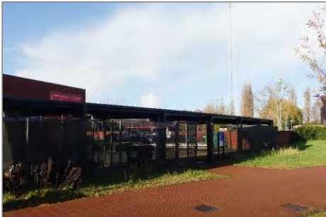
Afbeelding 2.7 | Deel 3: fietsenstalling bij entree
