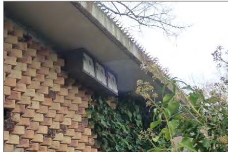
Afbeelding 5.6 | Deel 2: huismuskasten aan elektriciteitshuisje
