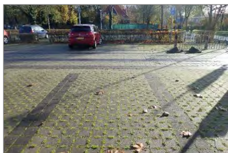
Afbeelding 4.5 | Deel 2: waterpasserende bestrating op parkeervakken
