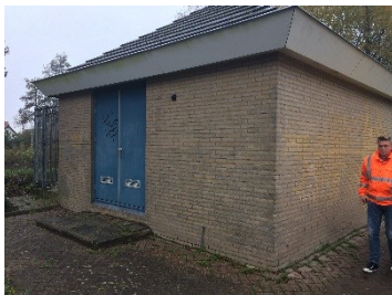
Figuur 1: Gemaal Nicolaaserf
