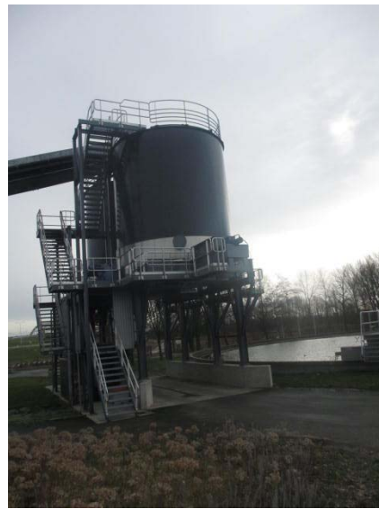
Foto 8 opslagtanks eindslib
