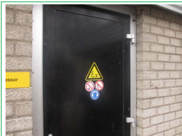
Toegangsdeur WKK ruimte
