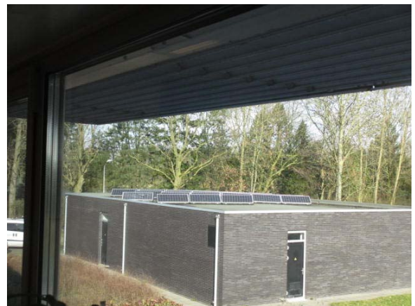
Foto 2 schakelgebouw met zonnecollectoren
