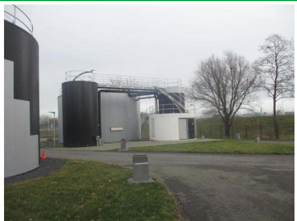
Foto 10 demontanks en installatie
