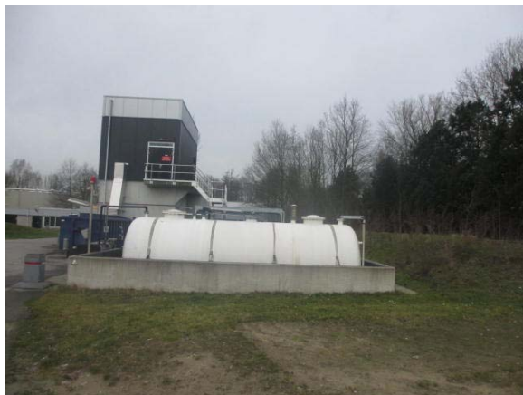
Foto 3 ontvangst- en zeefgebouw met mangaanchloride tank
