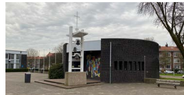
Huidige gebouw en/of kapel als inspiratie
