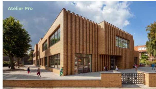
Geleding met uitstekend bouwdeel en in metselwerk
