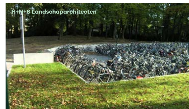
Half verdiepte fietsenstalling verdekt in groen
