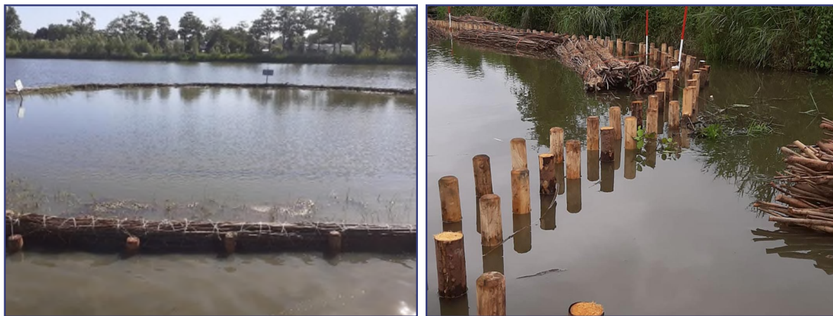
Figuur 4.2 illustratief voorbeeld van plaatsing palenrij t.b.v. oeverconstructie. (Van Aalsburg BV, 2021)
