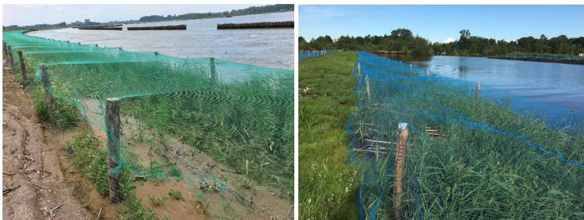
Figuur 4-1 Toepassing van antivraatrasters bij ontwikkeling NVO
