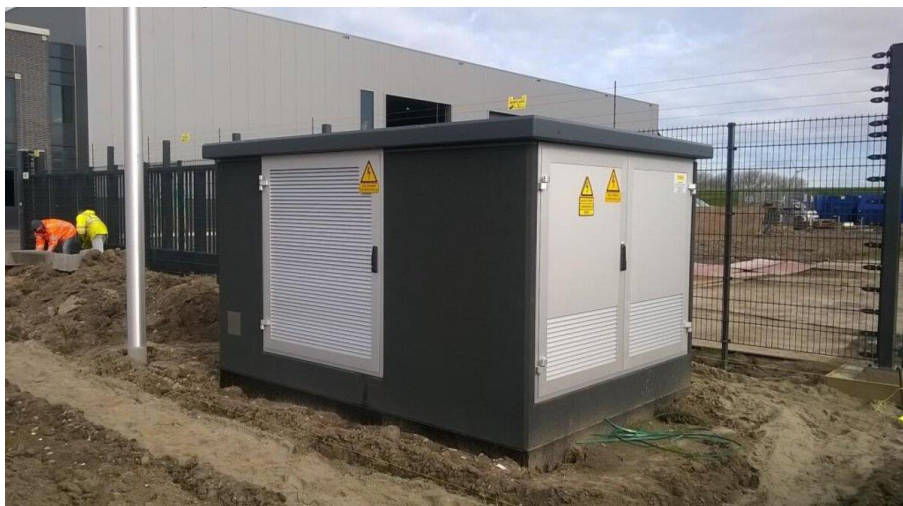
Figuur 9: compact station MS-aansluiting 2000 x 1900 x 2420 mm
