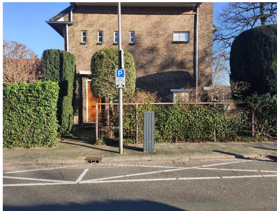
Figuur 1: Publieke laadpaal met netaansluiting
