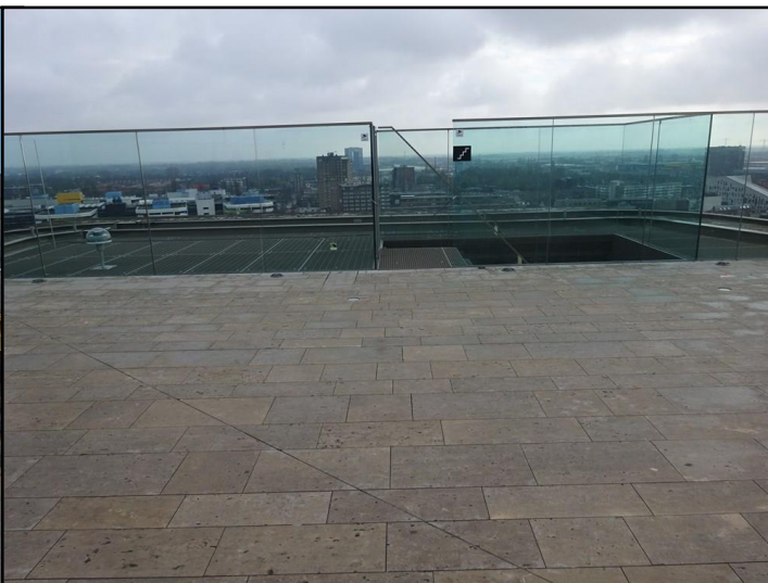
dakterras richting oosten
