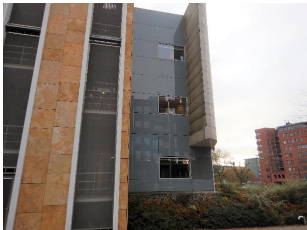
Foto 1 Glasgevel (tussen oud- en nieuwbouw) J.G. Sandbrinkstraatzijde.
