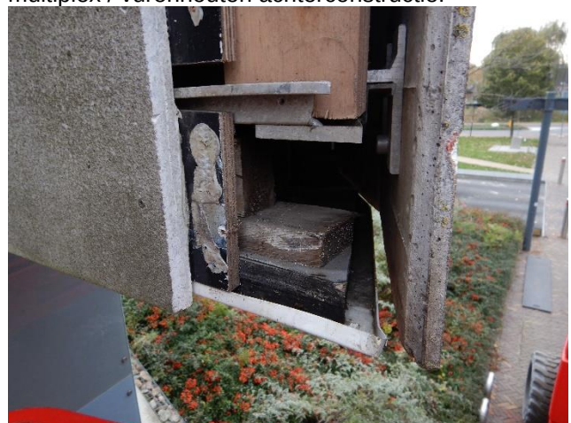
Foto 18 De multiplex gevelplaat is bevestigd tegen een multiplex / vurenhouten achterconstructie.
