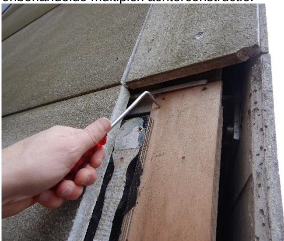
Foto 17 De multiplex gevelplaat is bevestigd tegen een multiplex / vurenhouten achterconstructie.
