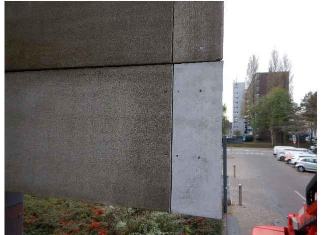
Foto 14 Incidenteel is een polymeerbetonnen gevelplaat vervangen door een multiplex plaat.
