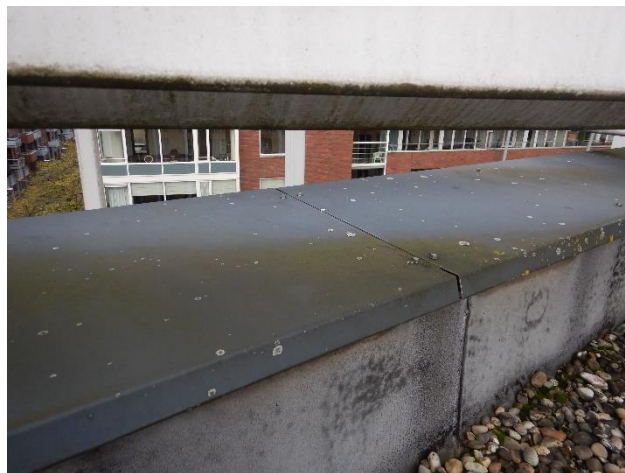
Foto 20 De bevestiging van de aluminium afdekkappen boven de natuursteen gevels is gecontroleerd.
