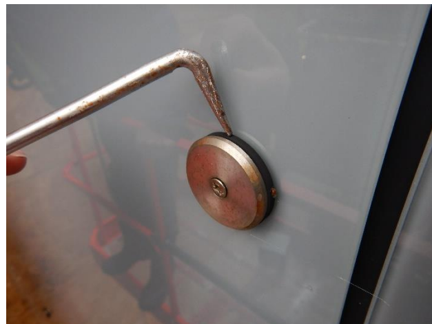
Foto 2 De glaspanelen zijn bevestigd met rvs schroeven en rozetten tegen onbehandelde vuren houten stijlen.
