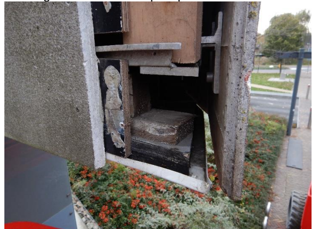
Foto 16 De multiplex gevelplaat is bevestigd tegen een multiplex / vurenhouten achterconstructie.
