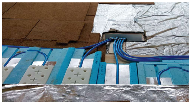
Figuur 14: Foto vloeropbouw
