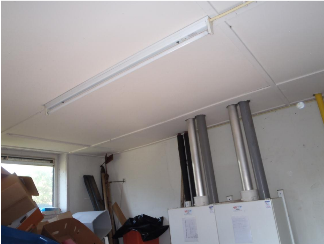
Foto 1, plafondbeplating cv ruimte, géén asbest
