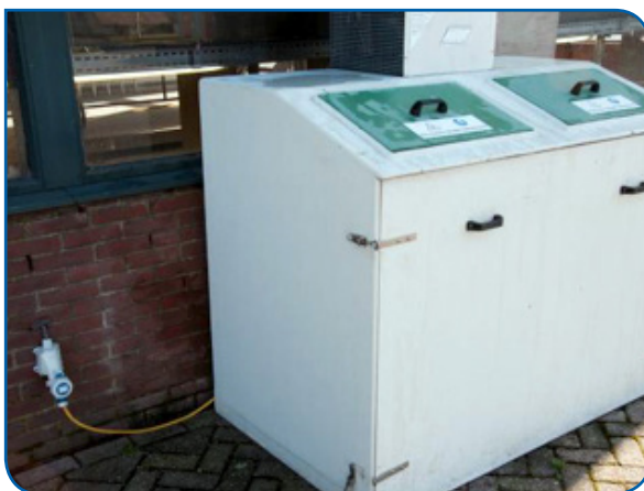
FOTO 3-5 KOELING WAAR KADAVERS TIJDELIJK WORDEN OPGESLAGEN. DE KOELING IS VOORZIEN VAN GEVAARSYMBOLLEN EN EEN GEBODSPICTOGRAM VOOR HET DRAGEN VAN HANDSCHOENEN.
