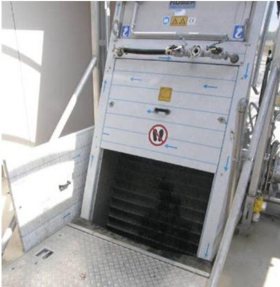
FOTO 2-2 GROFVUILROOSTERGOED MACHINE (VOORZIJD). AFGESCHERMD DOOR BESCHERMKAP MET IMBUS-SLOT.
