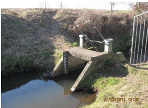
FOTO 2-6 HANDAANGEDREVEN ARBEIDSMIDDEL: STUW.
