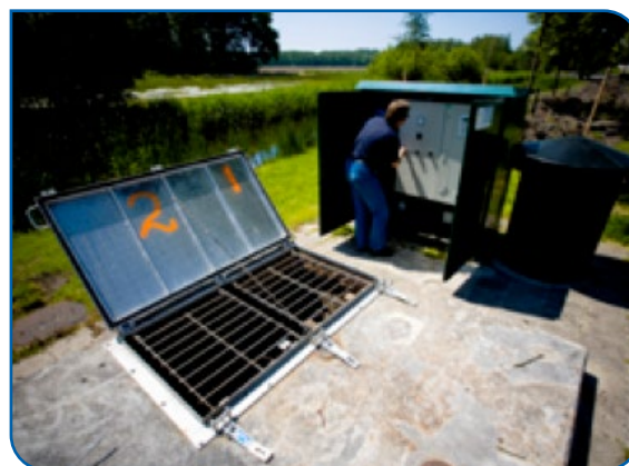
FIGUUR 2-6 VALROOSTER ONDER AFDEKKING PUT
