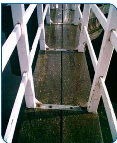
FIGUUR 2-20 HEKWERK BIJ SLUISDEUR
