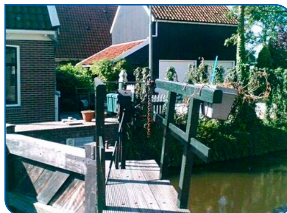
FIGUUR 2-4 BORDES BIJ SLUISBEDIENING
