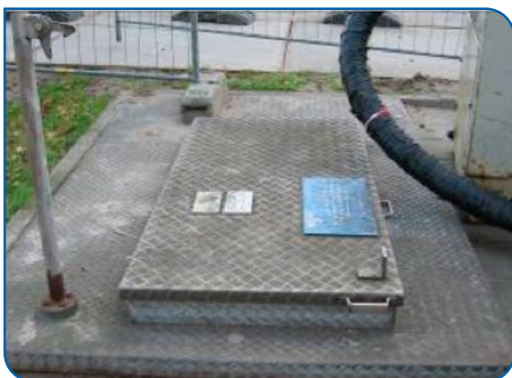
FIGUUR 2-5 STALEN AFDEKKING VOORZIEN VAN ANTI-SLIPPROFIEL
