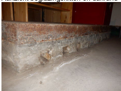
Aanzicht opstort en dilatatievoeg
