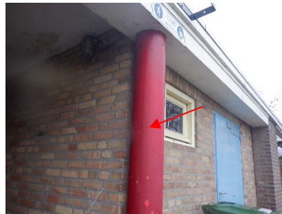
Aanzicht ac kanaal, kolom buitenberging
