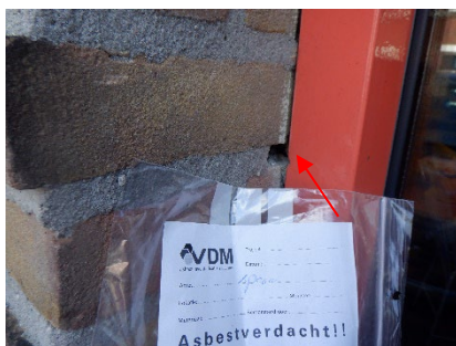
Aanzicht vlakke plaat, monster 7
