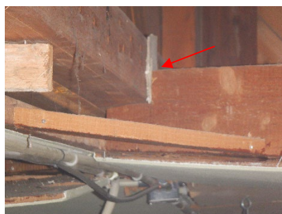
Aanzicht vlakke plaat, tussen balklaag dakconstructie ruimte 05
