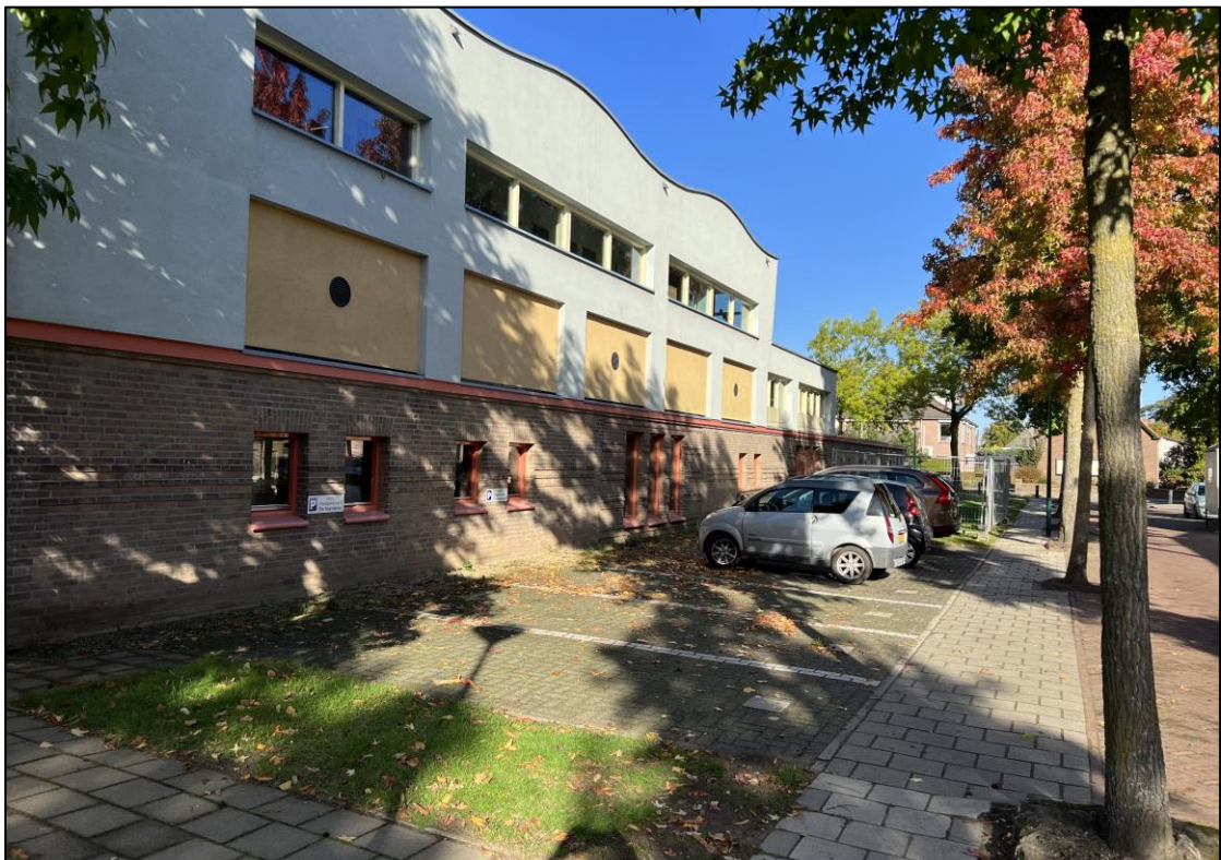
Afbeelding 25: Foto met zicht op de basisschool waarop te zien is dat de basisschool door de jaren heen is verticaal is uitgebreid.
