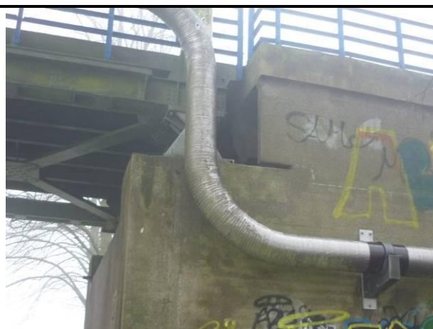
Kabeldraagconstructie
