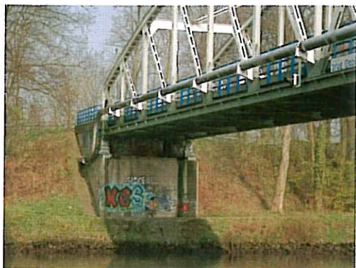
Landhoofden en aanbruggen
