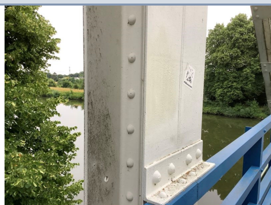
Bouwdeel: Hanger (boogbrug) Nadere specificatie: Staander westzijde
