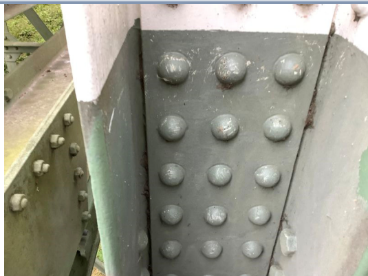
Bouwdeel: Kolom Nadere specificatie: Kolom nabij inspectie wagen
