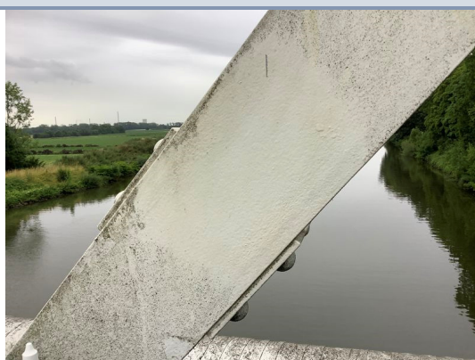
Bouwdeel: Windverband Nadere specificatie: Windverband midden brug
