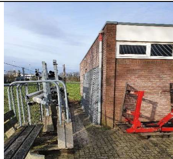
Ingang technische ruimte, linkerzijdepand
