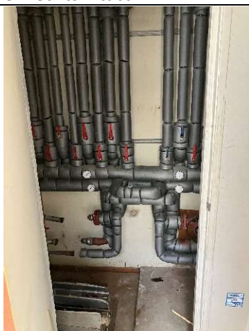
Leidingwerk afgesloten en aangesloten CV ketel
