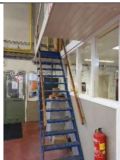
Route naar CV-installatie
