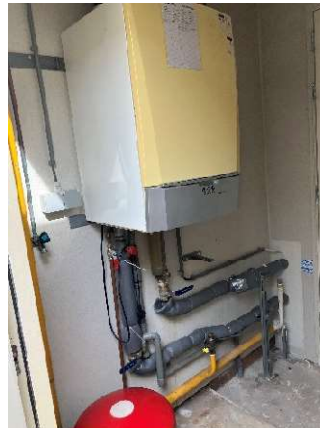
Cv links afgesloten
