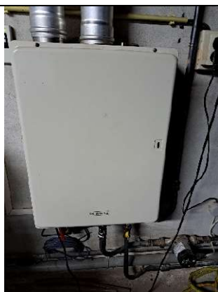
Doorstroomtoestel
