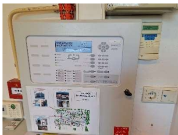
Aanzicht hoofdbrandmeldpaneel receptie
